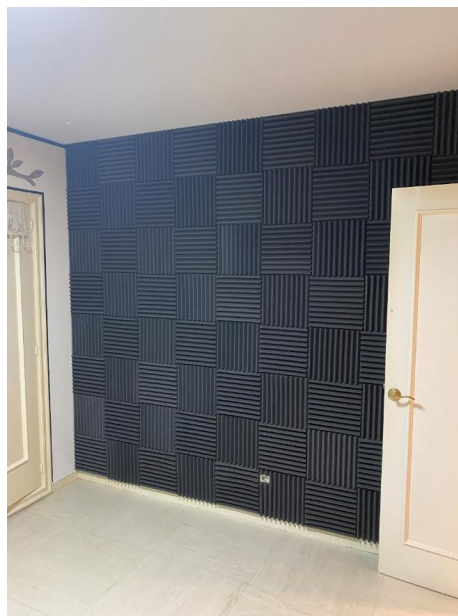
Revestimiento acústico en habitación de planta sótano
