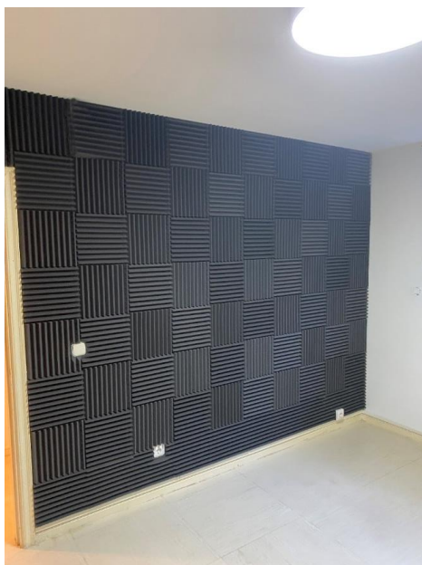
Revestimiento acústico en habitación de planta sótano
