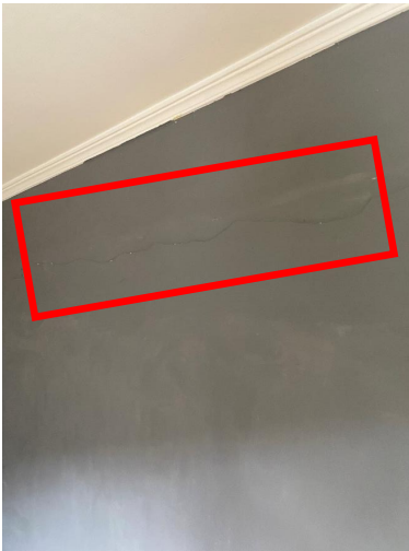
Grietas en pared de habitación 5 y defectos en ejecución de tabique de separación.
