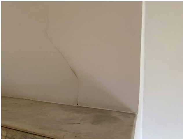
Grieta en pared de chimenea
