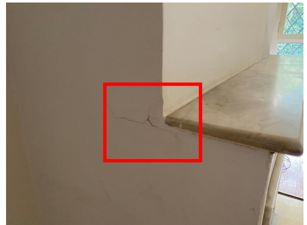
Grieta en pared de chimenea
